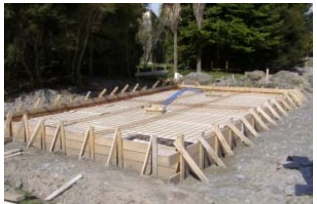
Arriba y abajo: Los cimientos del Hábitat para las ranas de la Isla Maud de Orana durante la primera inspección antes de la pre-vierta de los cimientos de hormigón.
