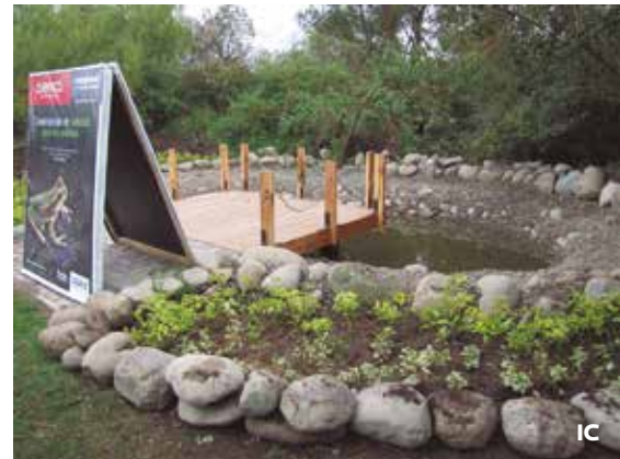
Figura 16. Construcción de pozas para anfibios urbanos.
